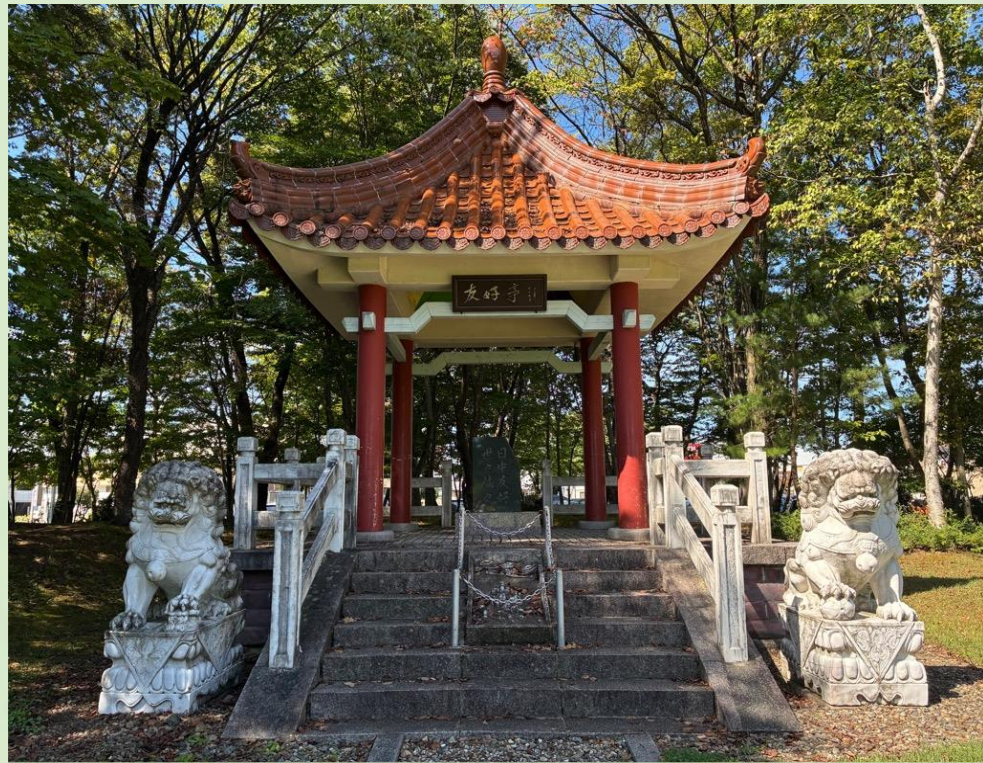
詩歌の森公園に建設された「友好亭」写真
